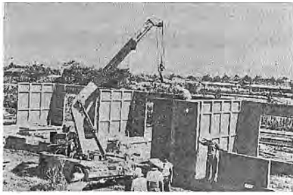
図 2.67 建設中の量産公営住宅 *38
