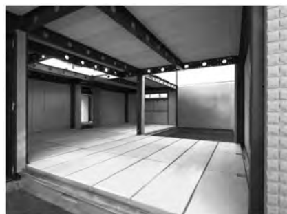
図 2.39 システムラーメン構造内観 （旭化成ホームズ）（旭化成ホームズ提供）
