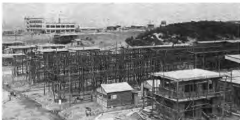
図 1.9 軽量鉄骨による公営住宅（名古屋市営住宅） *10
