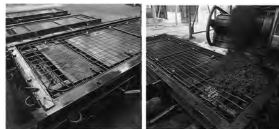
①型枠・鉄筋カゴセット ②コンクリート打設
