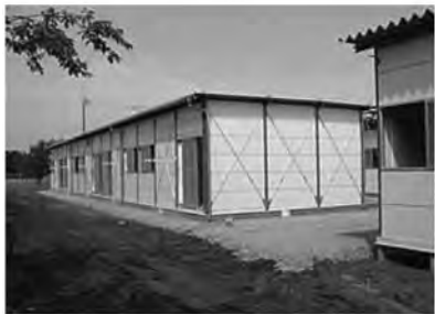
宮城県北部の応急仮設住宅（寒冷地対策仕様）
