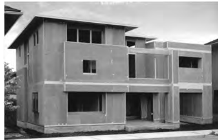
図 2.86 パネルの組立 (ミサワホーム提供)
