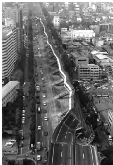
図 1.48 橋脚ごと横転した阪神高速道路神戸線
