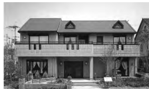
図 1.39 ゼフィール (大和ハウス工業、昭和 62 年)
