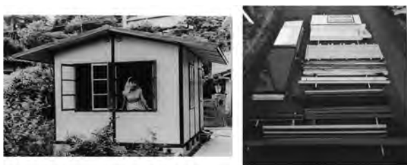
図 1.12 ミゼットハウス外観（左）と部品（右） *8 （大和ハウス工業、昭和 34 年）
