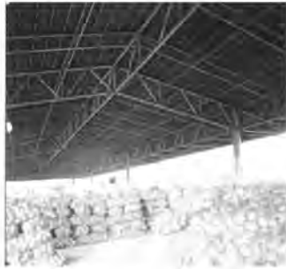
図 1.11 初期の本格鋼管構造建築 出典：大和ハウス工業二十年史
