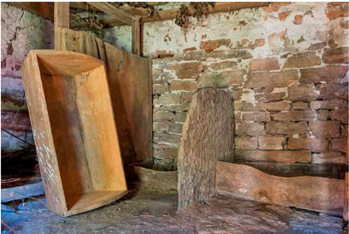
Figur 45. Detalj av bevarat fähus i Trib erga by, med spiltor skilda åt av upprättstående kalkstensflisor liknande de rekonstruerade fähusen i Eketorp. Foto: Daniel Lindskog.
