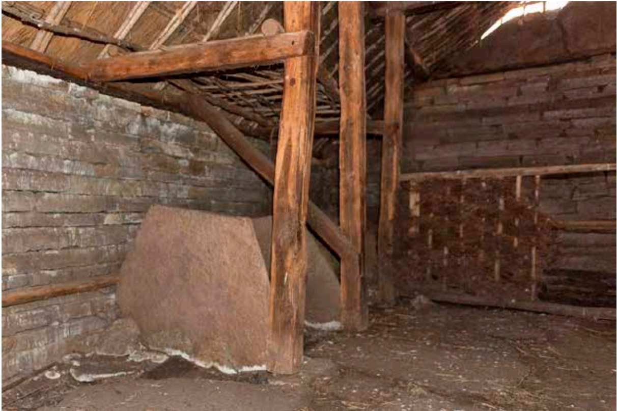
Figur 44. Detalj av rekonstruerat fähus i Eketorp, med spiltor skilda åt av upprättstående kalkstensflisor. Foto: Daniel Lindskog.
