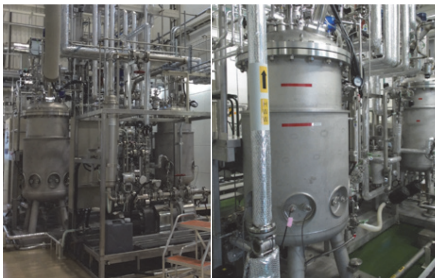
図7 フェノール製造パイロット設備
