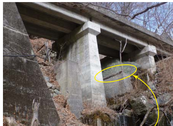
黒河内森林鉄道の橋脚跡：現在の林道の橋脚下に残る
