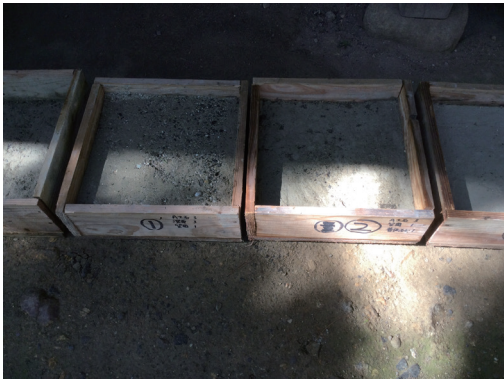
写真35 土間の材料の品質試験
