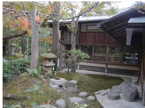
写真39 竣工状況(露地南側)
