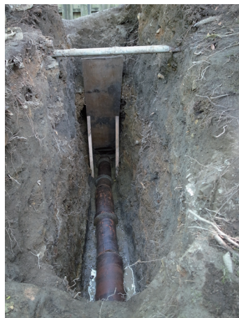
写真16 陶管の敷設状況
