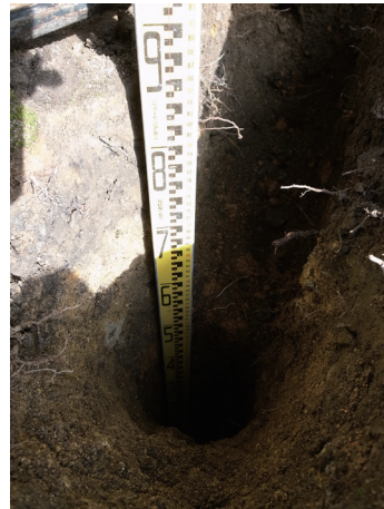
写真22 浸透枡の掘削状況
