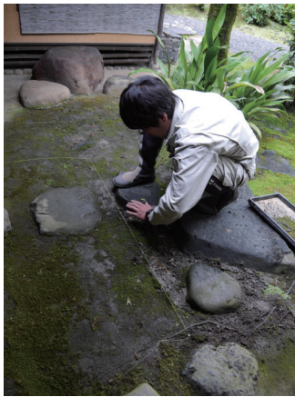
写真26 苔の剥ぎ取り作業
