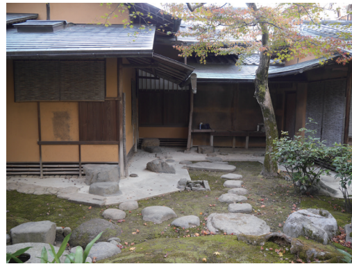
写真38 竣工状況(露地東側)
