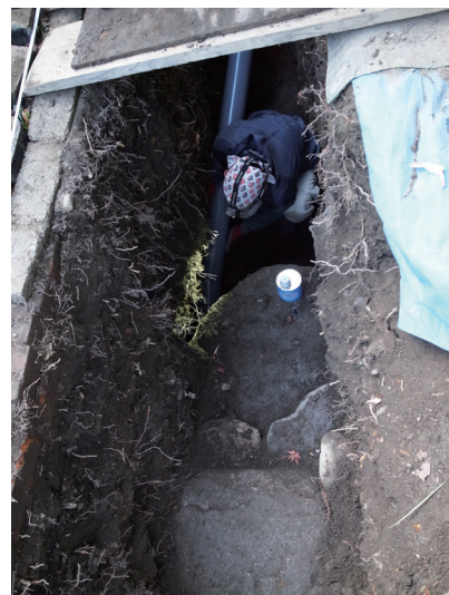
写真19 塩ビ管の挿入作業
