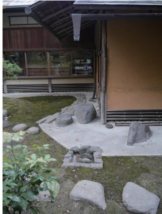
写真41 竣工状況（露地の躰口付近）
