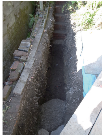
写真18 人孔東方掘削状況
