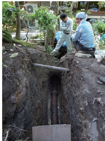
写真15 築山の掘削状況
