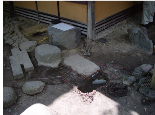
写真32 土間の輪郭の調査
