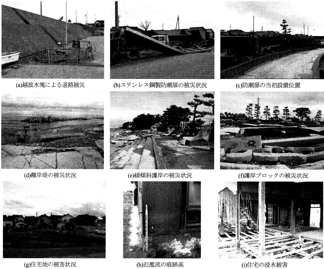
写真-1 富山県入善町芦崎地区の高波被害状況
