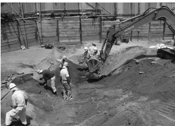
挿図写真3 中央流路西肩検出作業風景
