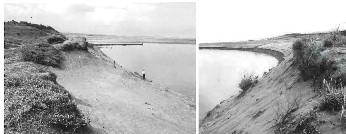
昭和27年頃、日向川河口は白木、青塚の中間で海に注いでいたが、季節風と川水の増水のため右岸の砂はつねに削られて崩れていった。
