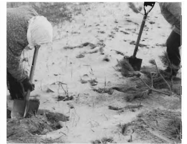
飛砂除去作業
