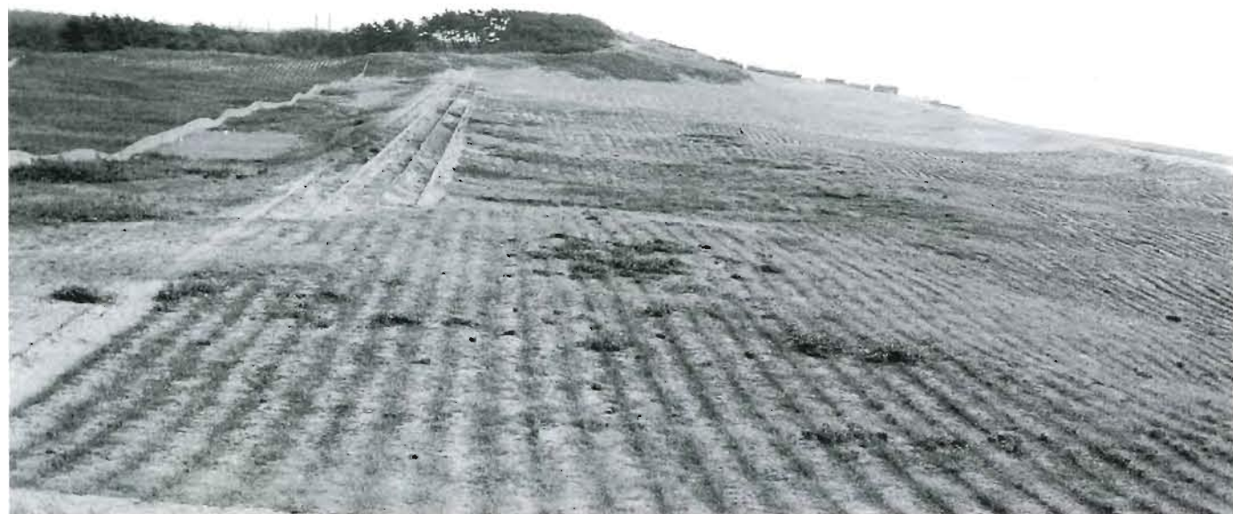
上:昭和20年代堆砂垣施工/下:昭和30年代のクロマツ植栽、砂草植栽
