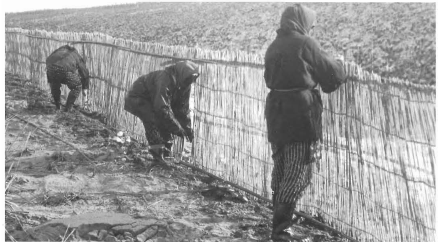
よしず、押竹施工中
