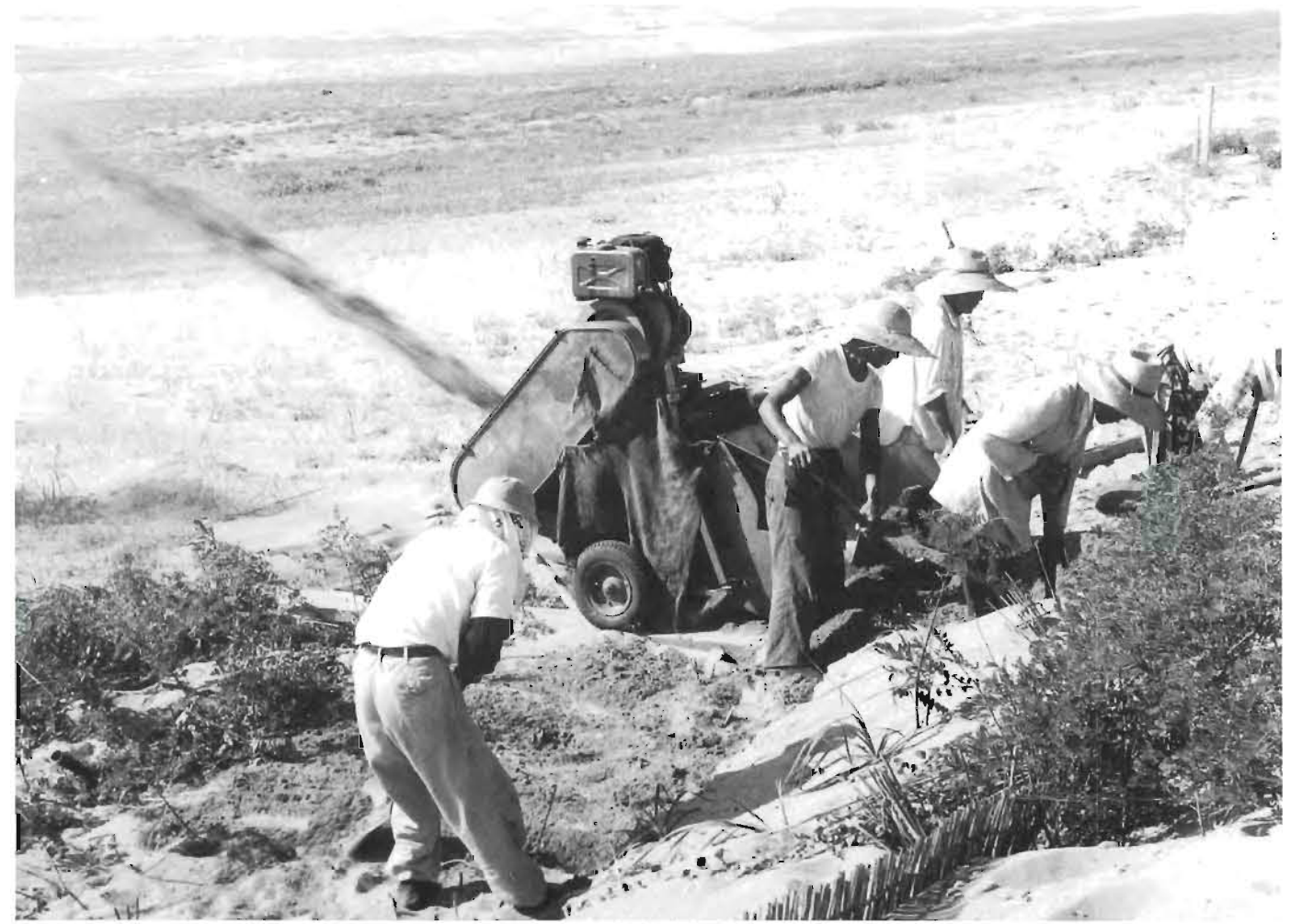
ドイツ製ジェットコンベアでクロマツ前線および防風垣の堆砂を掘り起す。砂を投入するとたちまち遠方に散布し得て、きわめて便利であった。(昭和33年)
