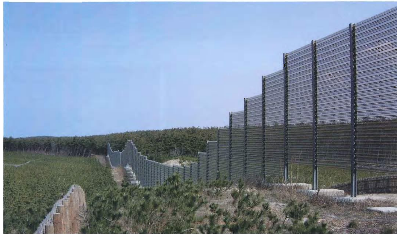
1135林班/マツカレハ等被害地へのクロマツ植栽と後方クロマツ林保護のため鋼製防風柵設置
