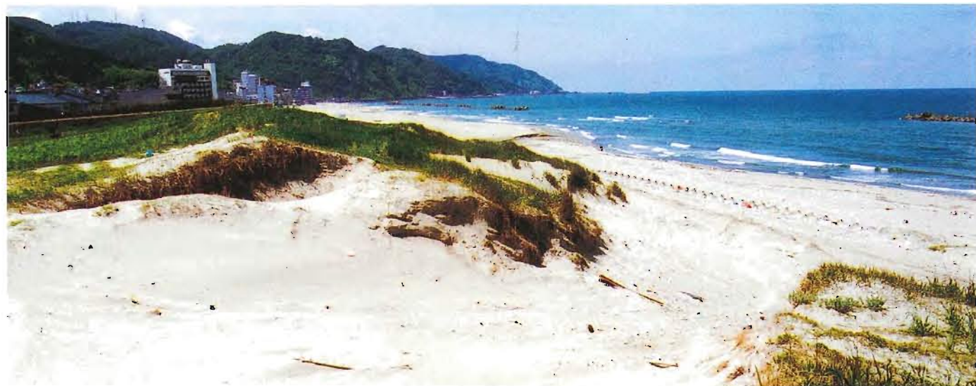
強風により破壊された前砂丘／海岸前砂丘は強風(特に11月から3月にかけては10~20m/s)により砂丘が破壊され広がり、砂の飛散によりクロマツを埋没させることから、砂丘の補修が必要となる。
