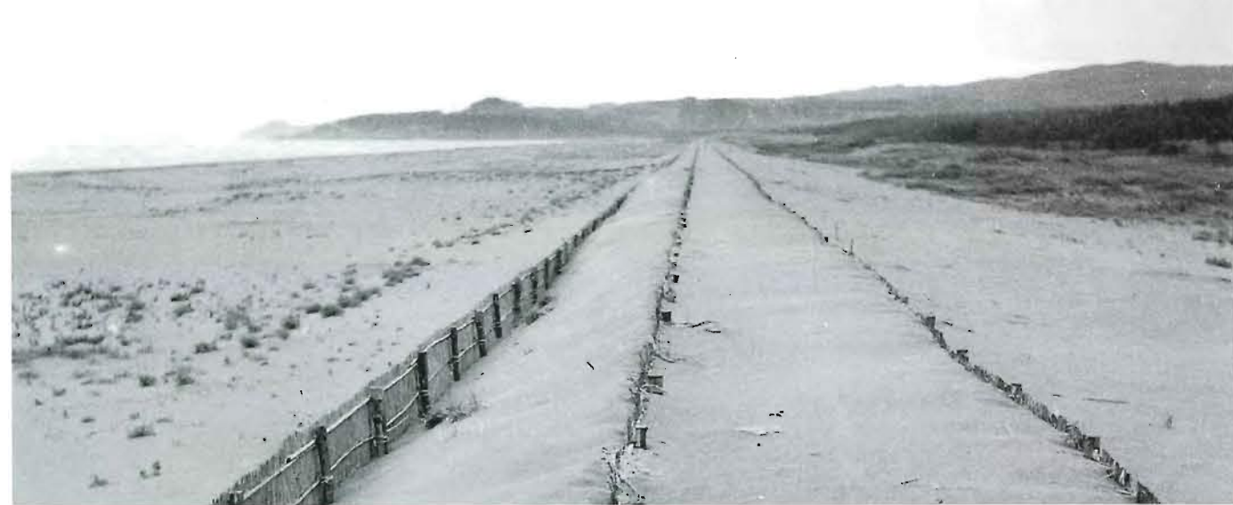
昭和27年頃/上:整地工/下:砂丘垣の堆砂状況
