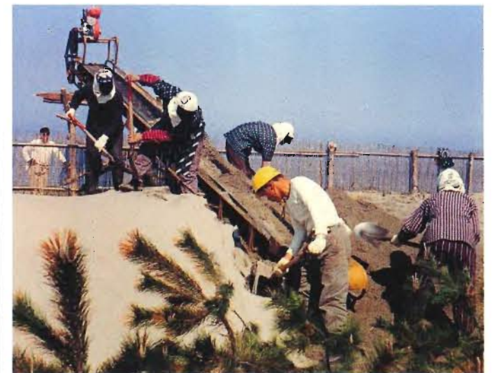
防風垣の堆砂をコンベアで運び出しているところ。
