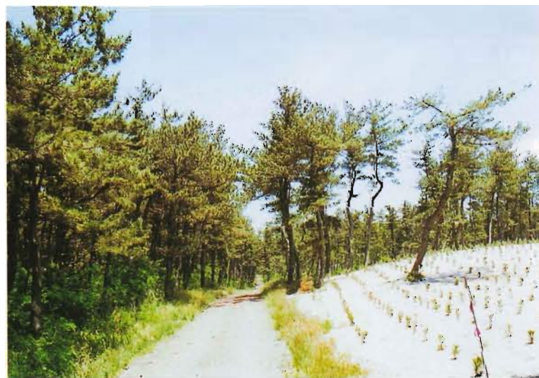
保安林管理道とクロマツ植栽／1134林班／平成14～15年度に総延長4,000mを施工
