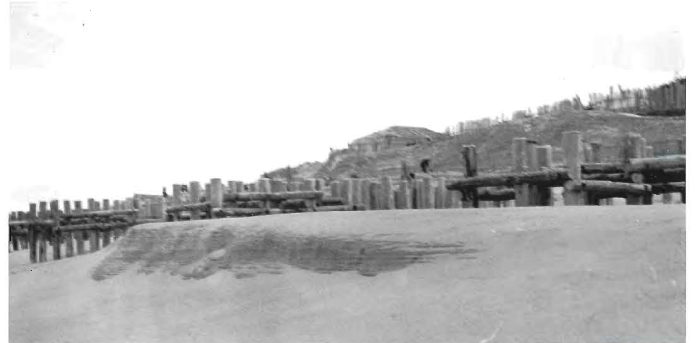
1135林班(昭和30年頃)／上:乱杭工の設置／下:堆砂状況
