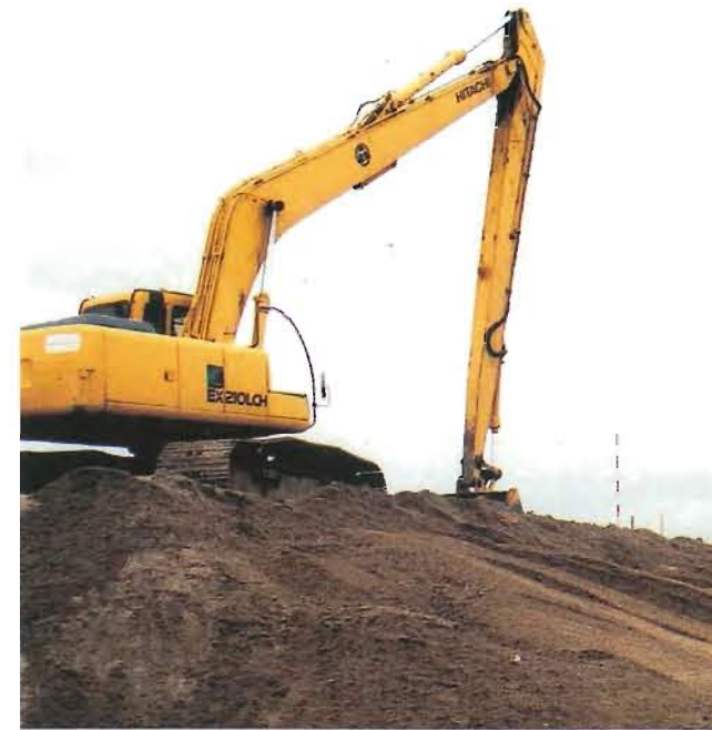
重機による砂丘造成
