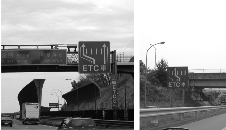
ETC車線の位置を示す車線案内標示板
