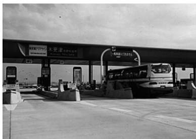
東京湾アクアライン木更津本線料金所 における試験運用
