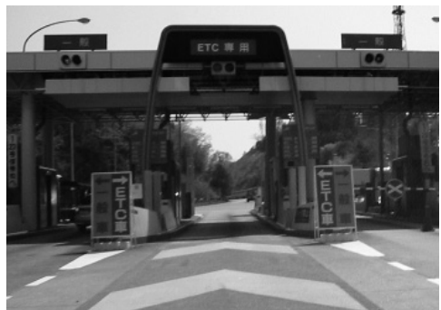
ETC車線の運用状況を示す車線表示板
