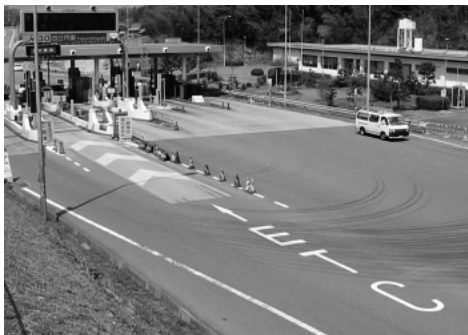
ETC車線への路面の誘導標示
