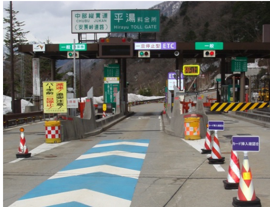
一旦停止型のETC専用レーン（安房峠道路平湯料金所）
